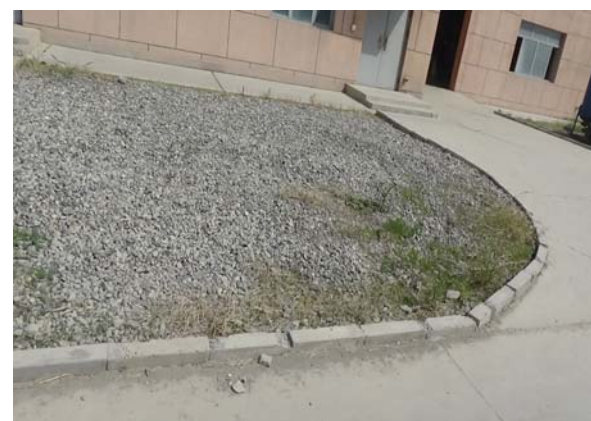
插图 6 厂区非硬化区域实施砾石压盖
