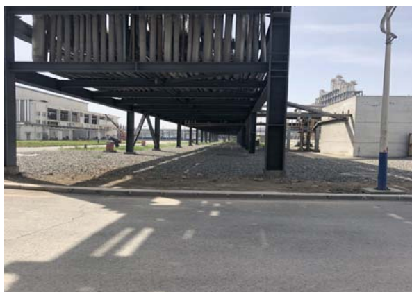
插图 5 厂区非硬化区域实施砾石压盖
