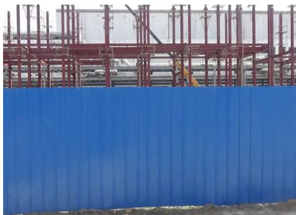
插图 12 施工过程中彩钢板围护
