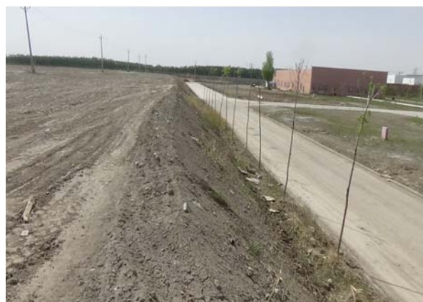
插图 3 临时渣场区场地平整情况
