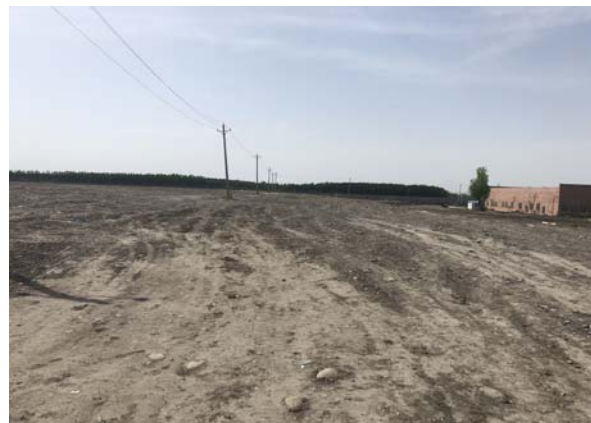
插图 4 临时渣场区场地平整情况
